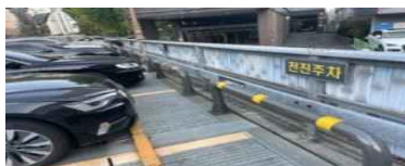
■ 주차 추락방지시설 설치
